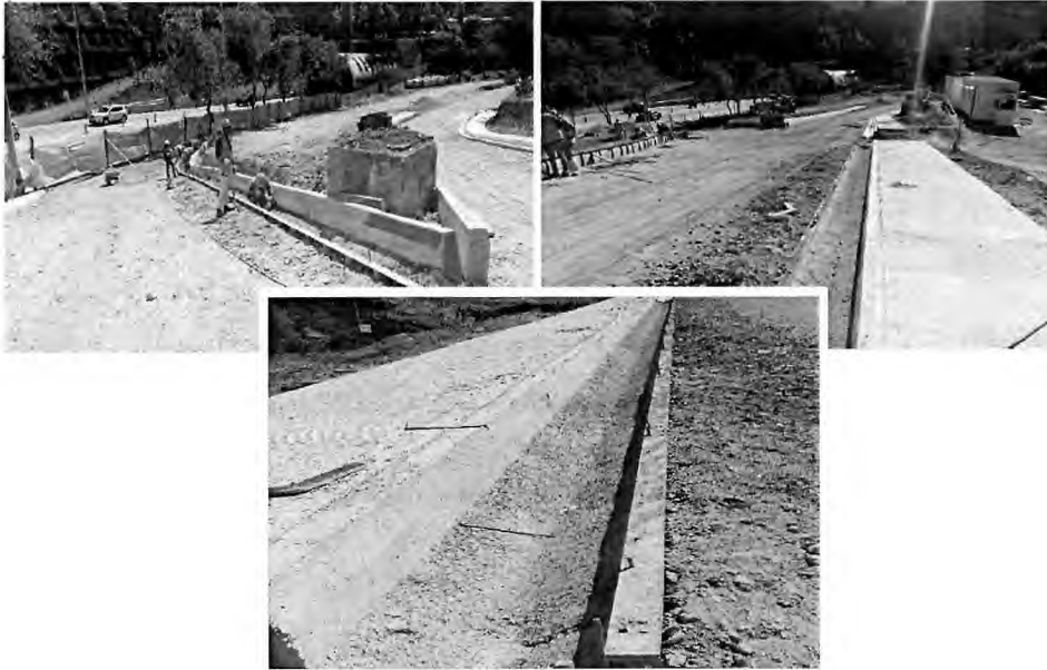
CUNETAS LATERALES, EXCAVACIÓN PARA CUNETAS FASE I – PROCESO CONSTRUCTIVO
