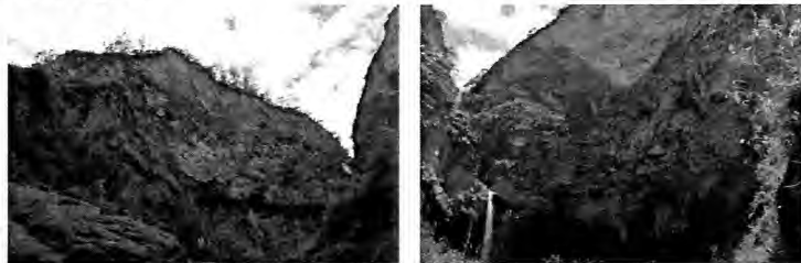
Talud zona del puente
