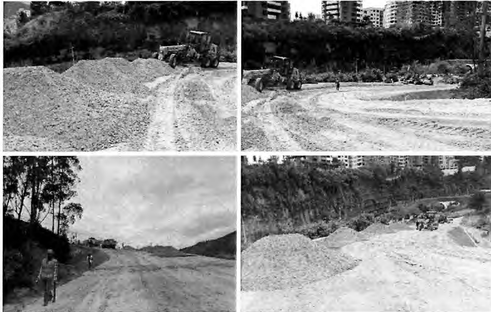
PAVIMENTO, SUBBASE GRANULAR CLASE 2
